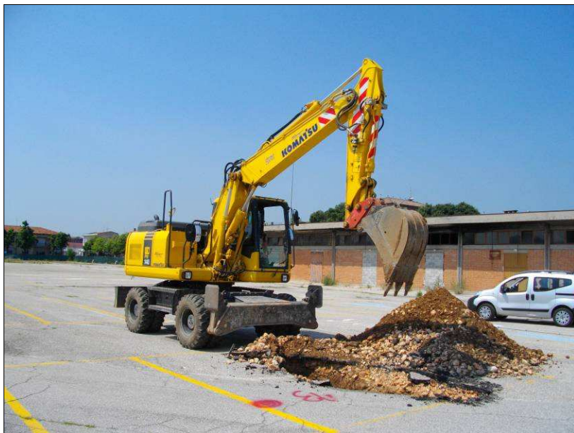
Postazione dello scavo.
