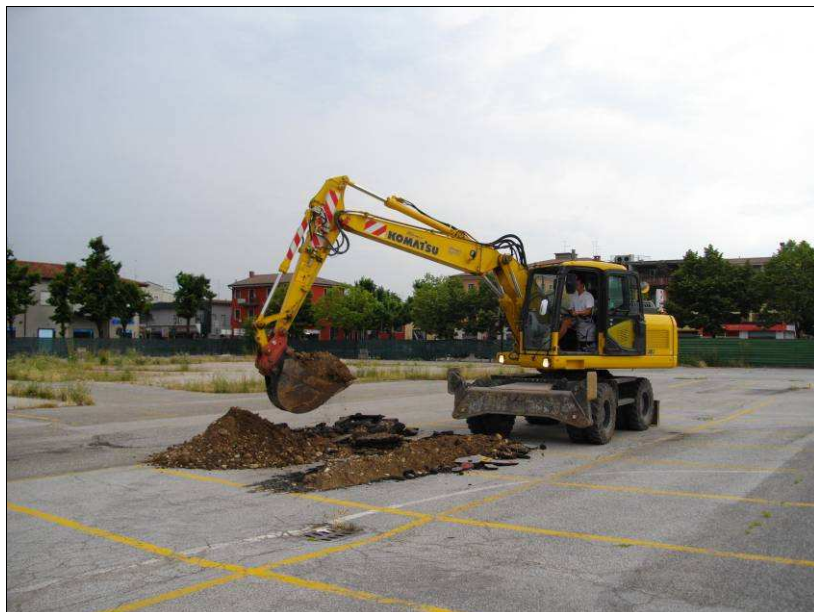
Postazione dello scavo.
