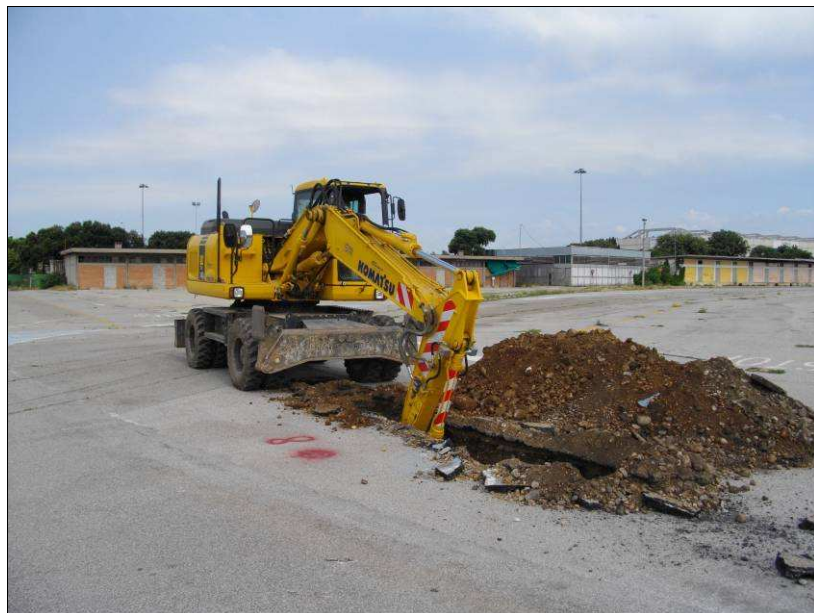
Postazione dello scavo.
