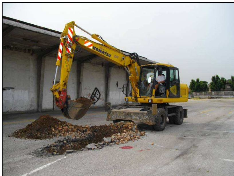
Postazione dello scavo.
