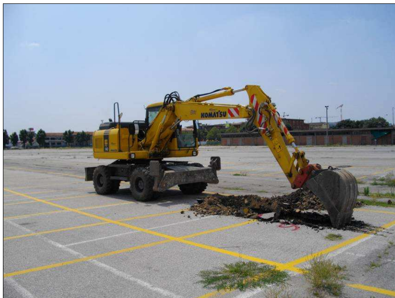
Postazione dello scavo.
