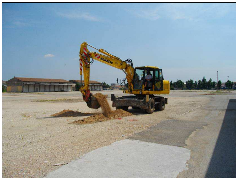
Postazione dello scavo.
