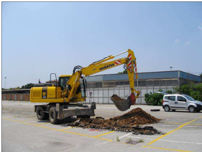
Postazione dello scavo.
