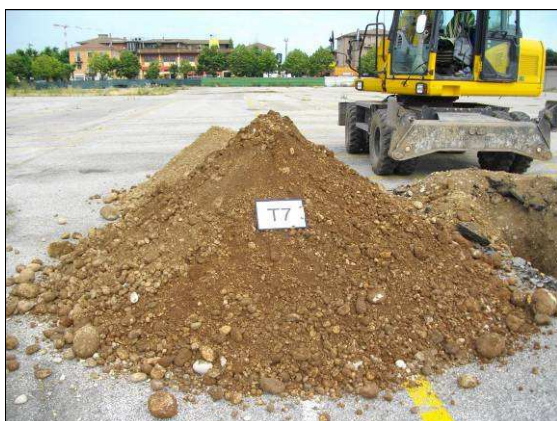
Cumulo di materiale riferibile all'Unità Rp (0.00 – 1.60 m).
