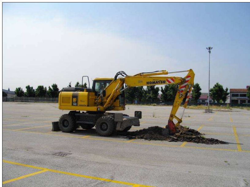
Postazione dello scavo.
