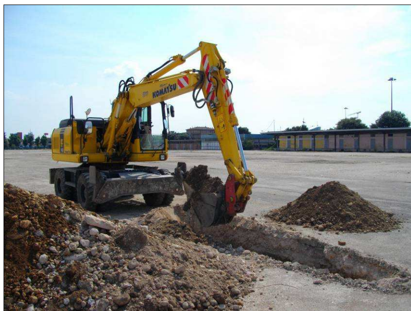
Postazione dello scavo.
