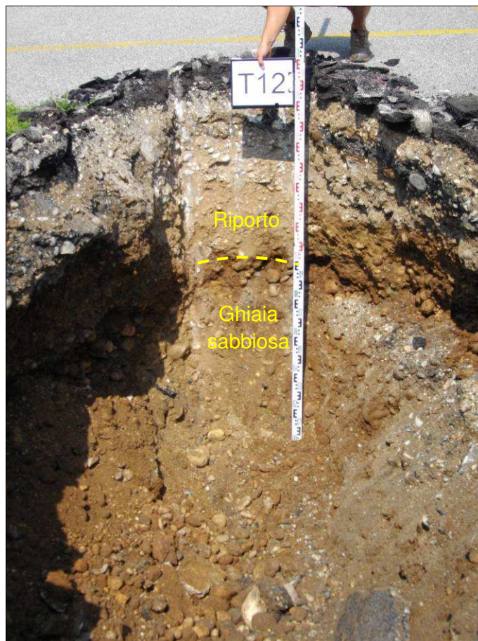
Particolare dello scavo
