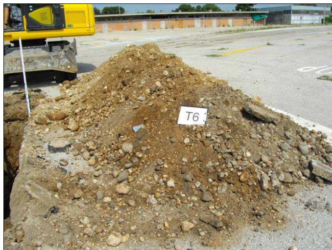
Cumulo di materiale riferibile all'Unità Rp (0.00 – 2.70 m).
