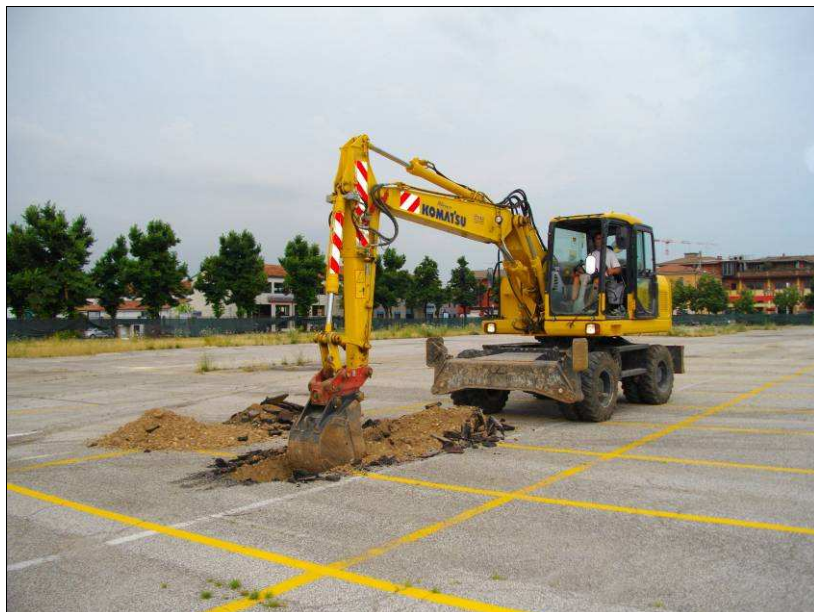
Postazione dello scavo.
