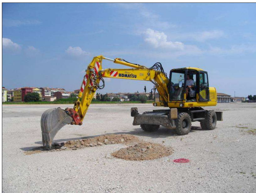
Postazione dello scavo.
